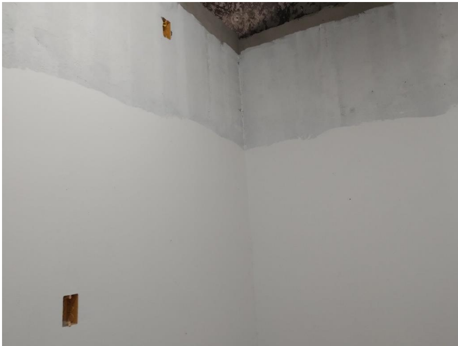
Figura 16 - Aplicação de massa corrida
