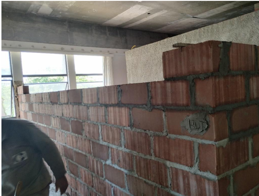
Figura 8 – Construção das paredes
