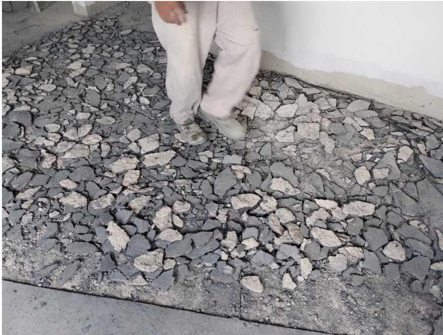
Figura 15 – Demolição do revestimento do piso
