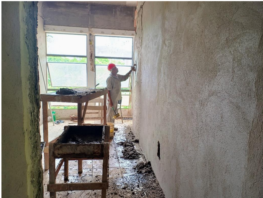
Figura 9 – Camada de reboco
