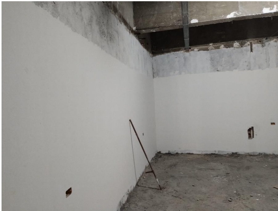
Figura 13 – Aplicação de massa corrida
