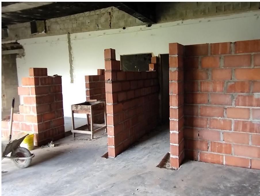
Figura 14 – Construção das paredes
