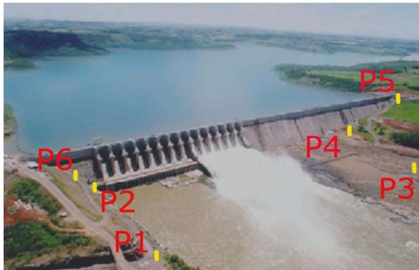
Foto 03 – Pilares que compõe a rede de monitoramento geodésico da barragem
