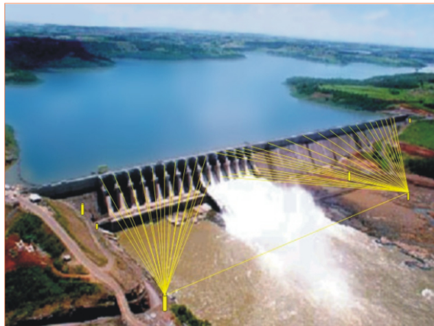
Figura 6 – Levantamento por irradiação - representação das Visadas a partir do Pilar 1 e 3
