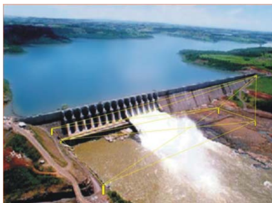
Figura 3 - Rede de pontos - Triangulação.
