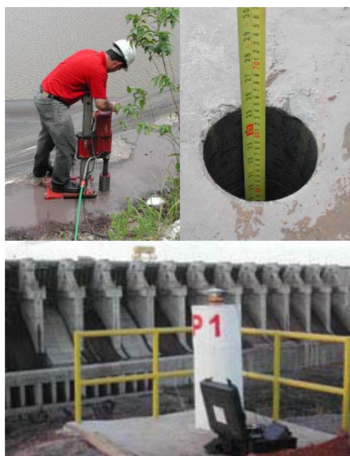
Figura 5 - Construção da fundação de um dos pontos e pilar finalizado.
