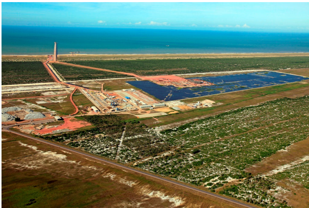
Figura 4: Visão geral das obras do CIPA (Victor Aquino, 2010).
