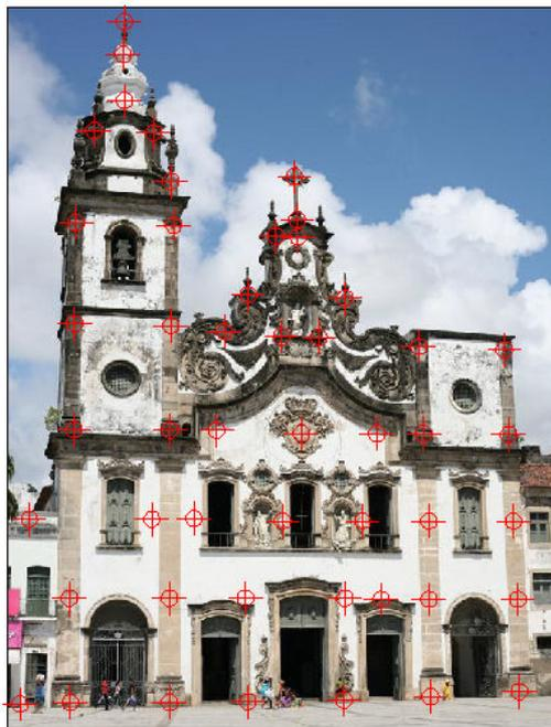
Figura 9: Distribuição dos pontos de controle na Fachada
