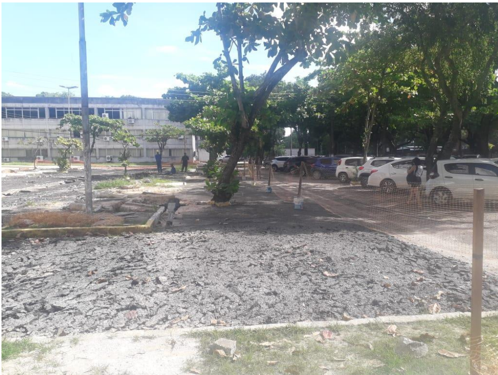
Figura 5 – Estacionamento- pavimento removido
