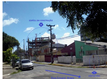
Figura 3 – Edifício em construção e ocupação GNSS do vértice EM2. Foto: Novembro 2013.
