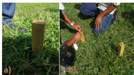
Figura 10 – Fixação dos pregos nas estacas (a) e amarração do fio a “nylon” (b). Foto: Janeiro de 2014.
