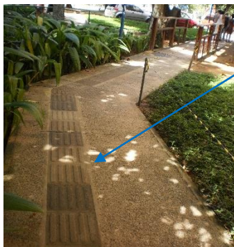
Figura – 9. Trecho com piso tátil na Escola de Dança/UFBA
