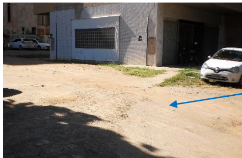
Figura – 8. Acesso com solo exposto sem piso adequado entre Escola de Dança e PAF V
