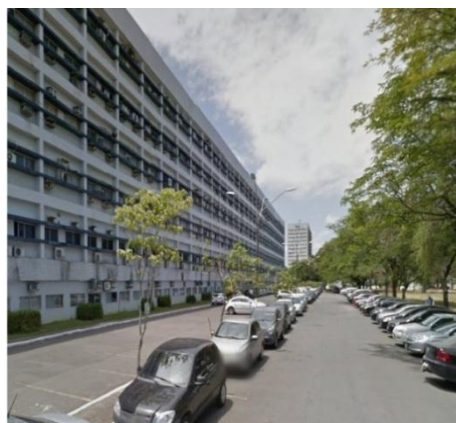
Figura 02 – Vista Aproximada do local onde as operações de campo ocorreram
